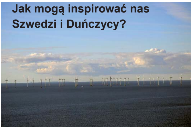
Elektrownia wiatrowa Lillgrund zlokalizowana na wodach cieśniny Sund
