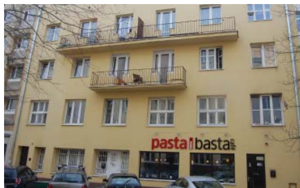
Dom przy ulicy Odolańskiej 5. Fot. P. Tanewski 2015.
