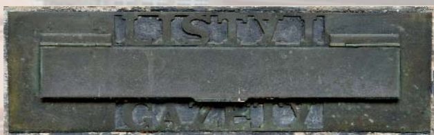
Zagadka nr 6: Wrzutnia na listy na frontonie budynku A. Fot. Maciej Górski
