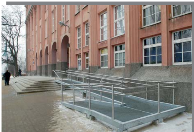
Windy, platformy przyschodowe i podjazdy w budynkach G, B, W
